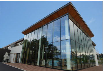
雄武町図書館（雄武町末広町二区）
