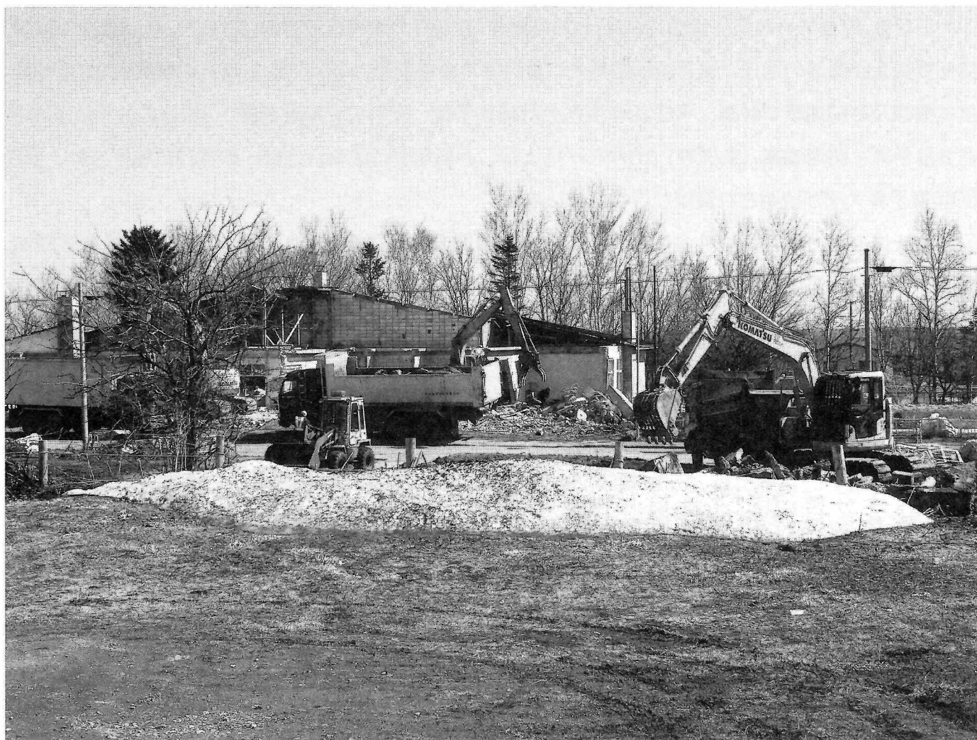
— 図書館建設のため解体作業が進む旧若草保育所 —
