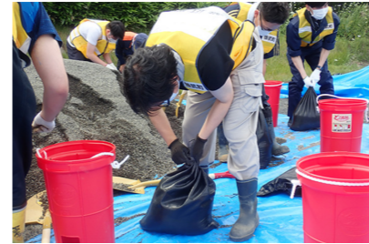
↑土のう作成①
