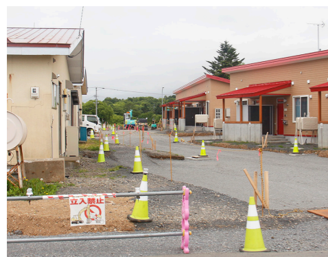
↑ 旭日公園4号線道路整備工事(7月下旬撮影)
