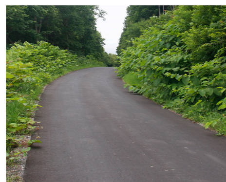
↑ 沢木2号線舗装整備工事(7月下旬撮影)
