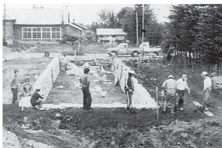
↑PTAによる簡易プール造成の様子
