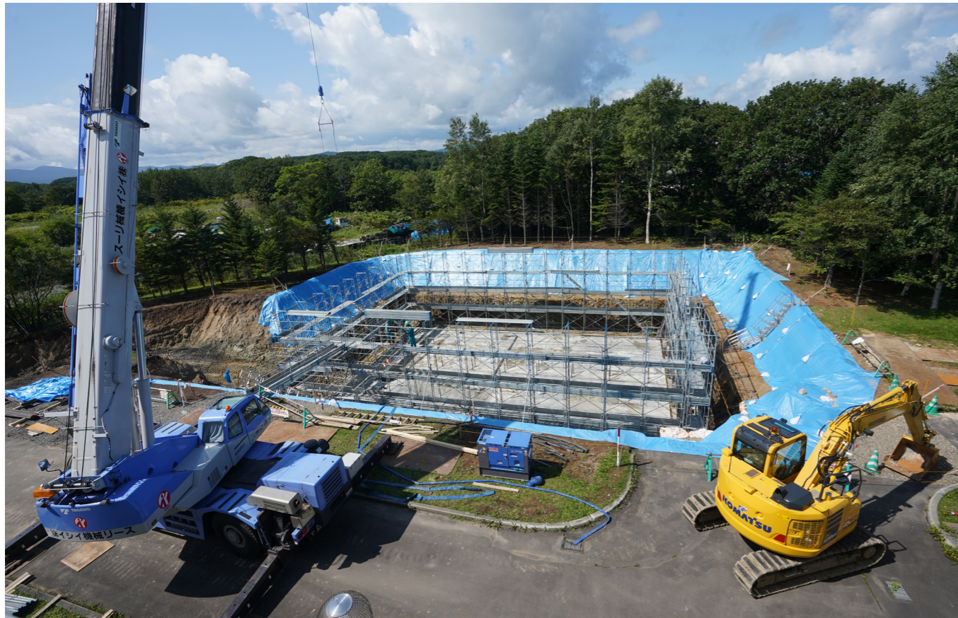
↑雄武浄化センターし尿受入施設工事現場(8月下旬撮影)
