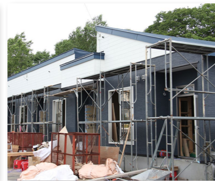
↑ 旧雄武農業開発事業所宿舍改修工事
