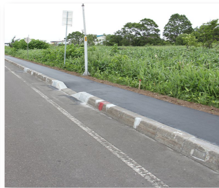
↑ 魚田14号線歩道改修工事
