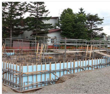
↑ 公営住宅新日の出団地建設工事
