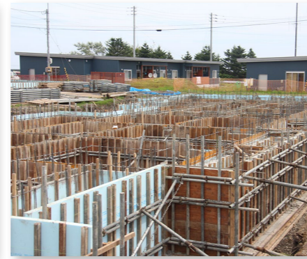
↑ 公営住宅新日の出団地建設工事
