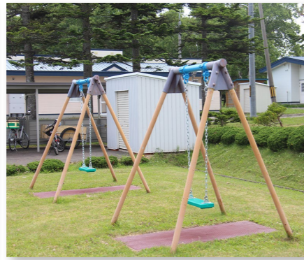
↑ 小学校遊具改修工事
