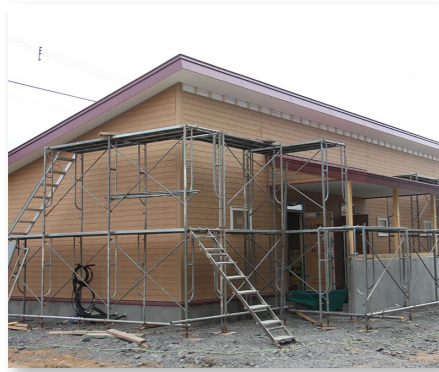
↑ 勤労者住宅建設工事
