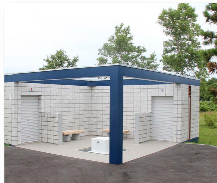
↑ 農村広場トイレ改修工事
