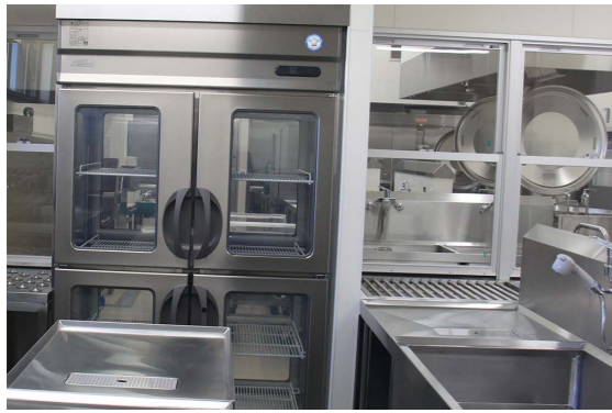
パススルー方式 各作業を部屋ごとに明確に区分し、食材だけを次のラインへ受け渡します。
