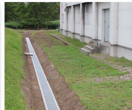
↑ 豊丘小学校排水改修工事
