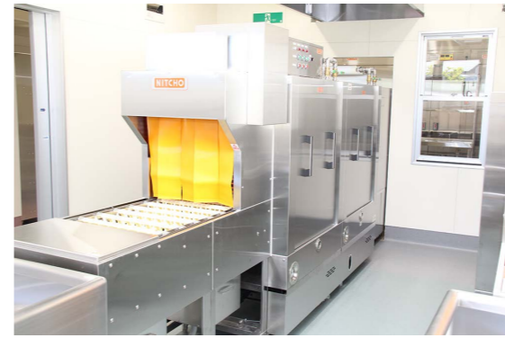
洗浄室 食器の種類ごとにベルトコンベヤー式で洗浄し、すべての食器などを約2時間30分で洗うことができます。
