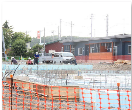
↑ 公営住宅新日の出団地建設工事
