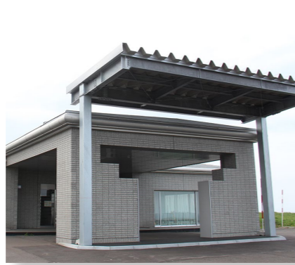
(衛生費) 雄武斎場車寄せ改修工事 支出済額 792万円
