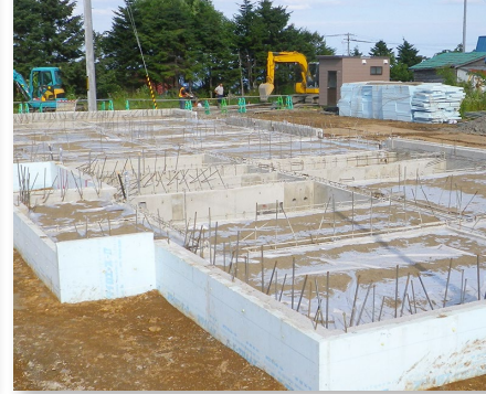
↑公営住宅新日の出団地建設工事
