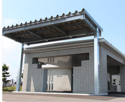
↑雄武斎場車寄せ改修工事
