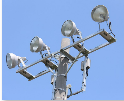
↑メモリアル広場照明整備工事
