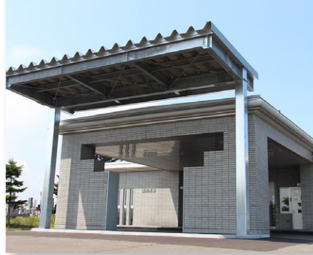
↑雄武斎場車寄せ改修工事
