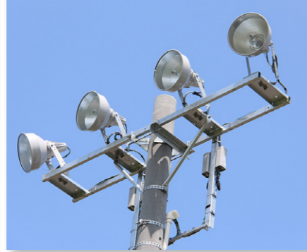
↑メモリアル広場照明整備工事
