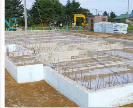
↑公営住宅新日の出団地建設工事
